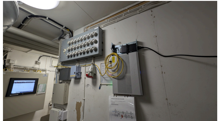
Äldre elcentral i fläktrum som bedöms vara uttjänt.
