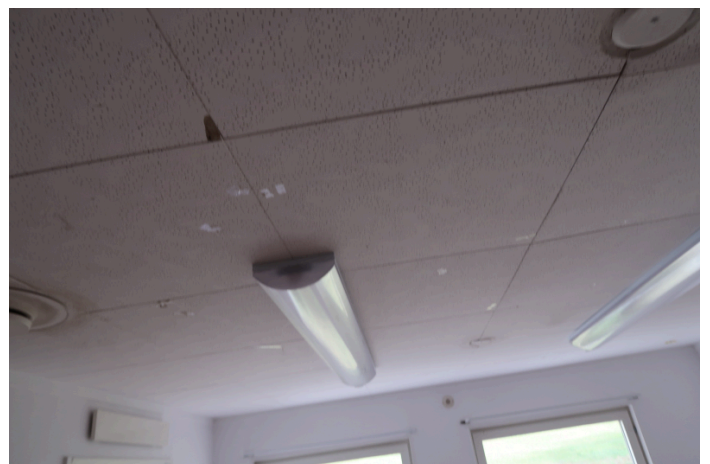
Exempelbild undertak med fastlimmade akustikplattor
