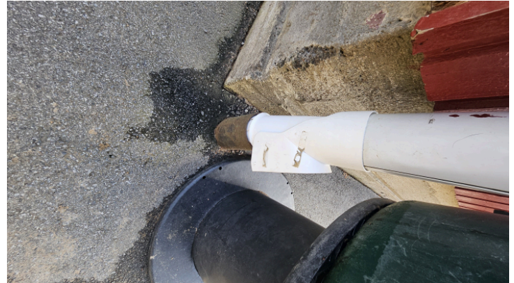
Anslutning av stuprör för takavvattning till markrör med rostutfällning.
