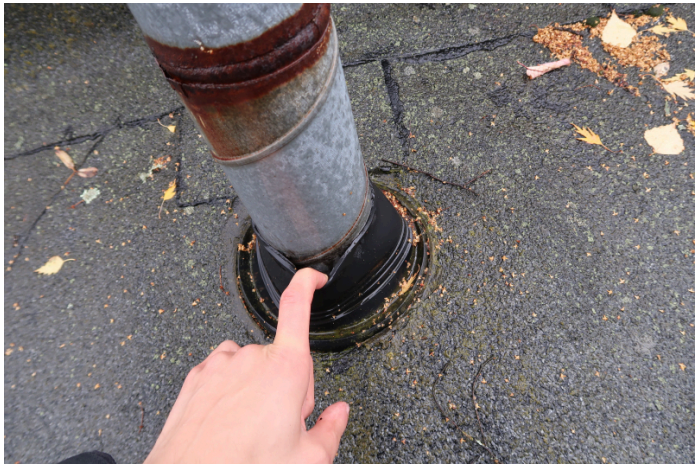
Avluftningrör av spirorör som är i behov av byte.
