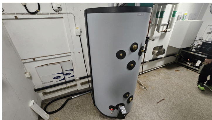
Akkumulatortank, NIBE EKS 500, för uppvärmning av tappvarmvatten.
