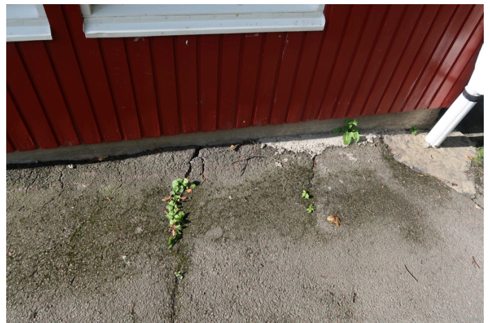
misstänkt dräneringsproblem nord/östra fasaden.
