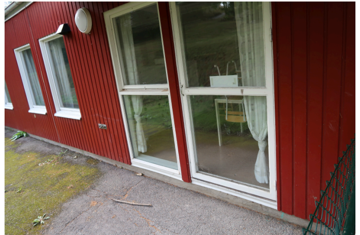
Utfackningsvägg med fönster.
