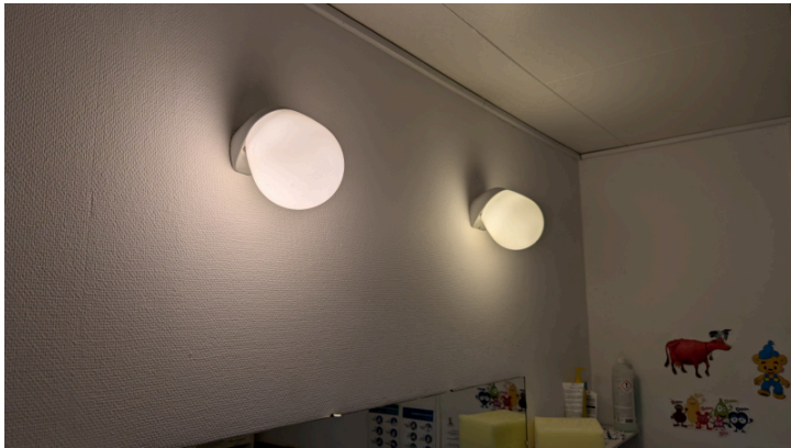
Referensbild av äldre armaturer från byggåret 1978 som ej bytts ut vid större armaturbyte.
